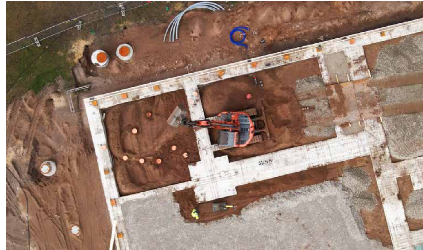
Die Baustelle in Steinhagen aus der Vogelperspektive.
