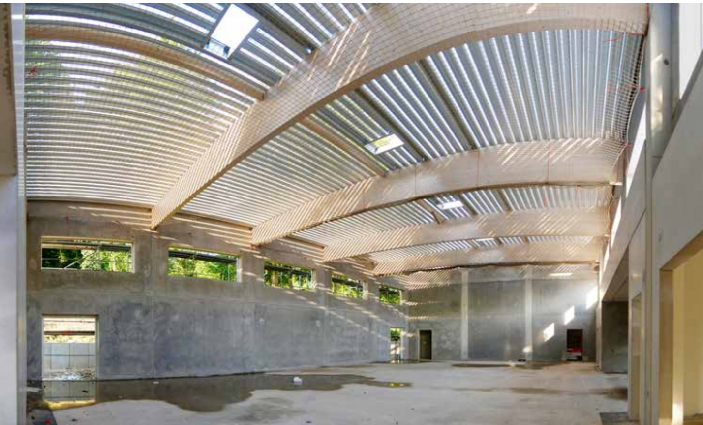
Die neue Turnhalle am Lipper Hellweg im Bau.
