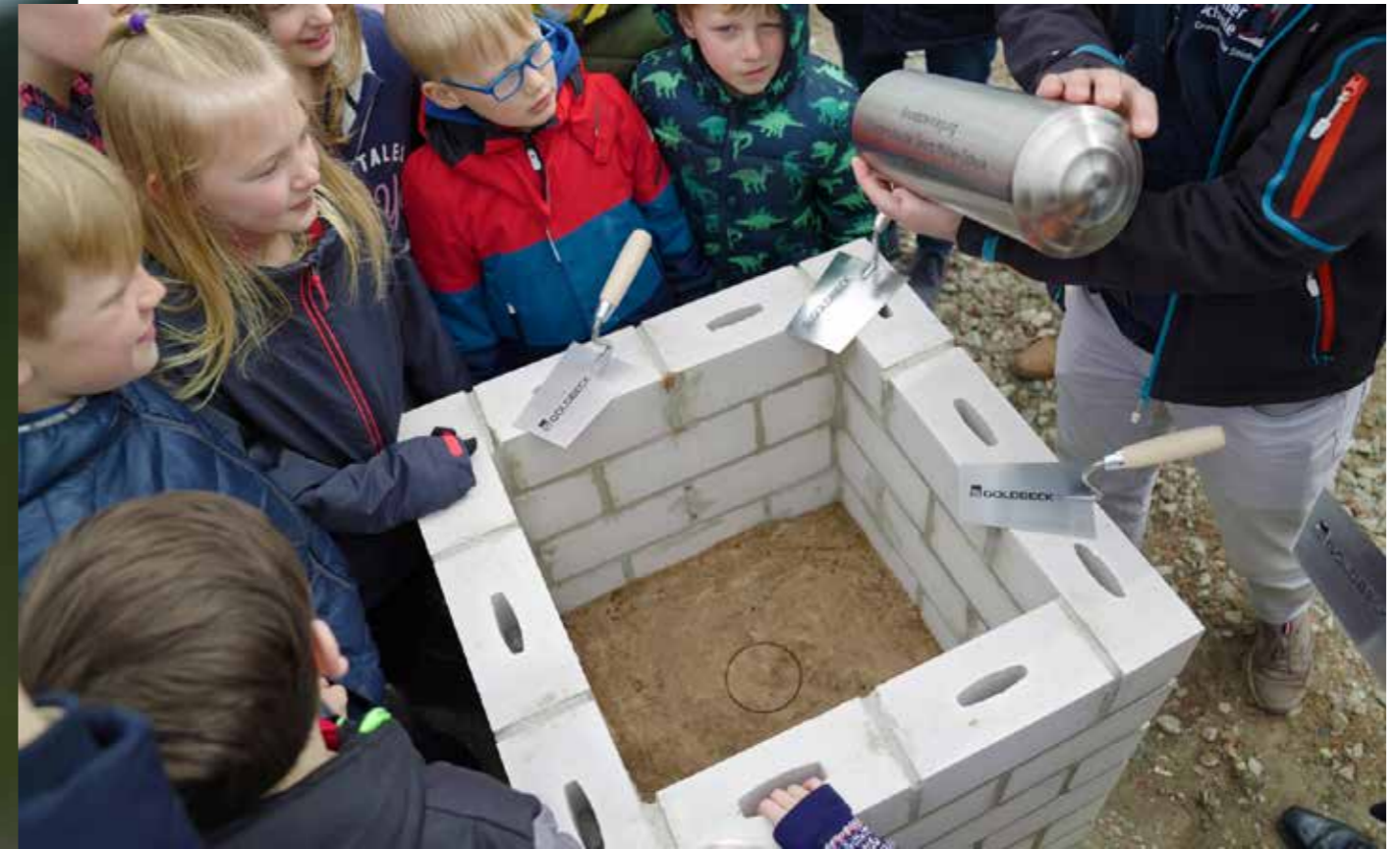
Eine Zeitkapsel wird bei der Grundsteinlegung im April eingemauert.
